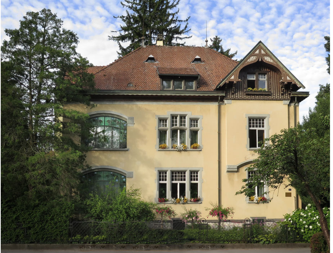
Ruhtalstrasse Architecte: Johann Nepomuk Bürkle Date de construction: 1900-1901
